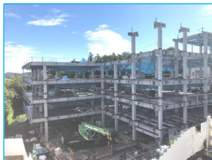
8月末 鉄骨骨組み
