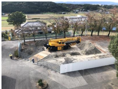
10月末 浄化槽設置工事
