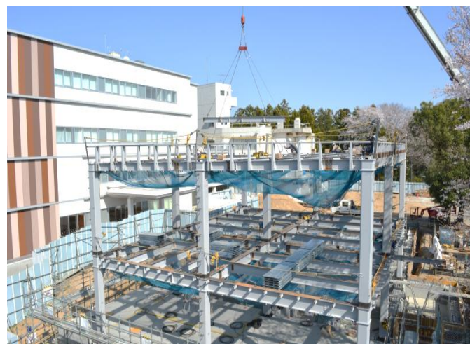
管理棟建築工事
